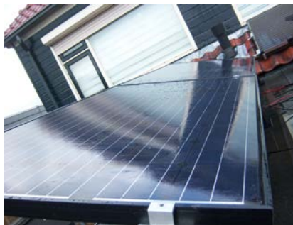
Eindbeugel (verschilt per paneel dikte)
